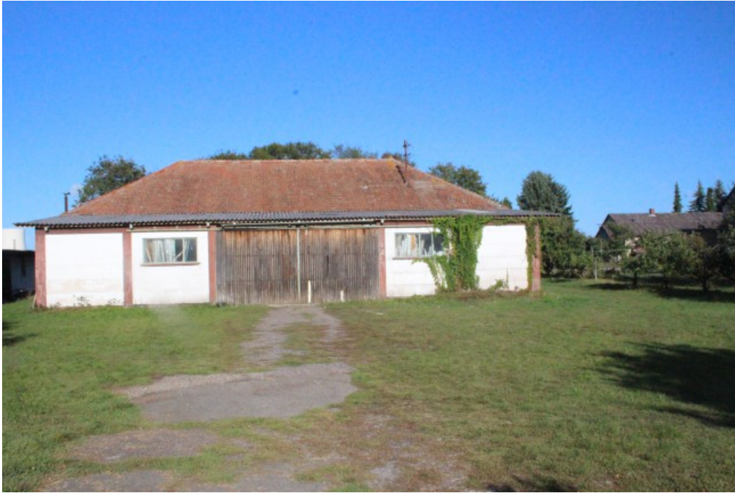
Abbildung 3: Südliches Flurstück Nr. 2672 mit Lagerhalle von Westen
